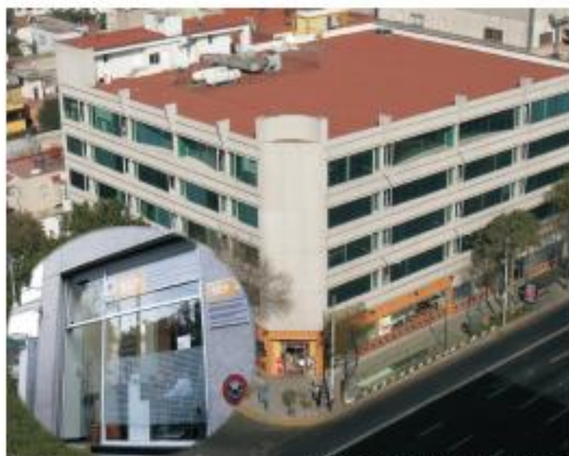
Edificio de la Dirección de Educación Especial, ubicada en: Calzada de Tlalpan No. 5161, Colonia Anáhuac, México, DF.
